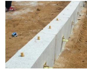
9.블럭핀 및 연결재 설치
