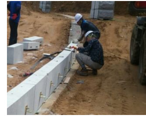
4.수평잡석 및 1단블럭 설치
